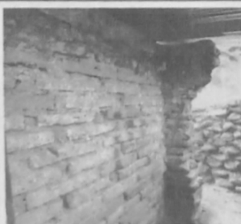
Foto 5: Se realizara mejoramiento de pared debido que es de adobe. En época de invierno por las lluvias el adobe tiende mojarse por dicha razón se está cayendo a pedazos
